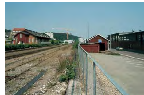
Fiskervej til højre er via Sverrigesgade kørende adgang til Fiskeri- og Træskibshavnene. Det smalle areal mellem vejen og banen nord for Østbanegården anvendes til skiftende formål, her værkstedsbebyggelse.
