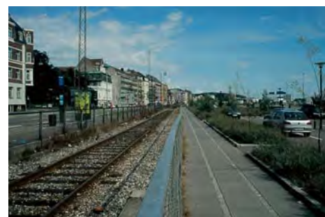
Grenåbanen set mod nord fra parkeringsanlæggets sti, med Skt. Olufs Plads i havnefronten til venstre.
