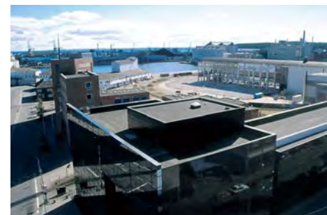
Udsigt over Havnehuset og arealet mellem det eksisterende havnespors kurve og Turbinehallen. I forgrunden Stevedorebygningen ved Toldbodgade.
