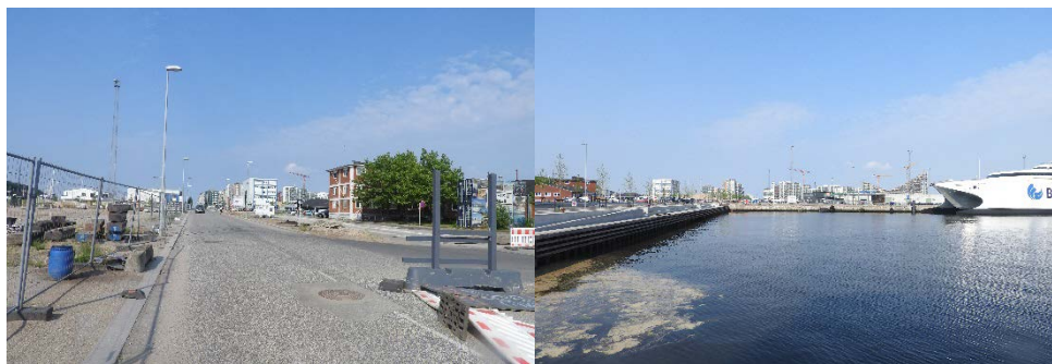
Figur 6-6 Området er præget af byggeri og anlægsaktiviteter, men nærheden til havnen er et markant karaktertræk
